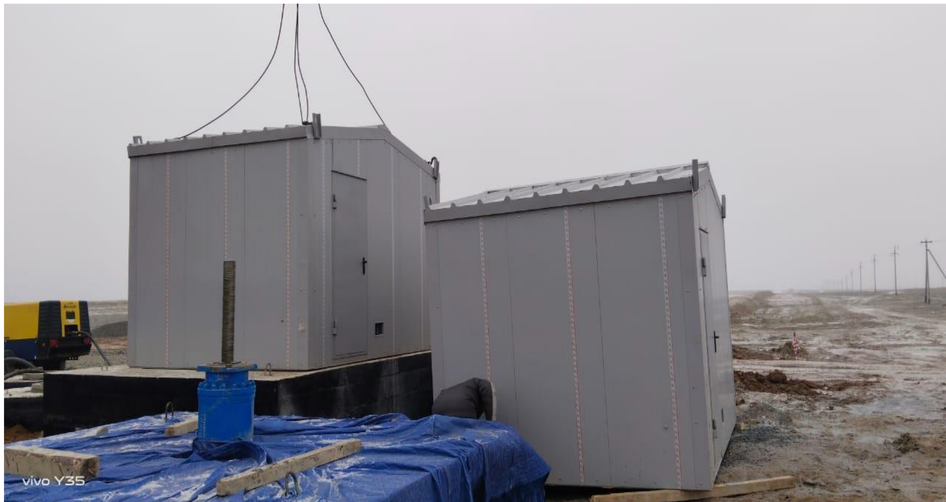
Монтаж блок-бокса для задвижки Ду1200 компании ЛКУ на 184 км комплекса 3
