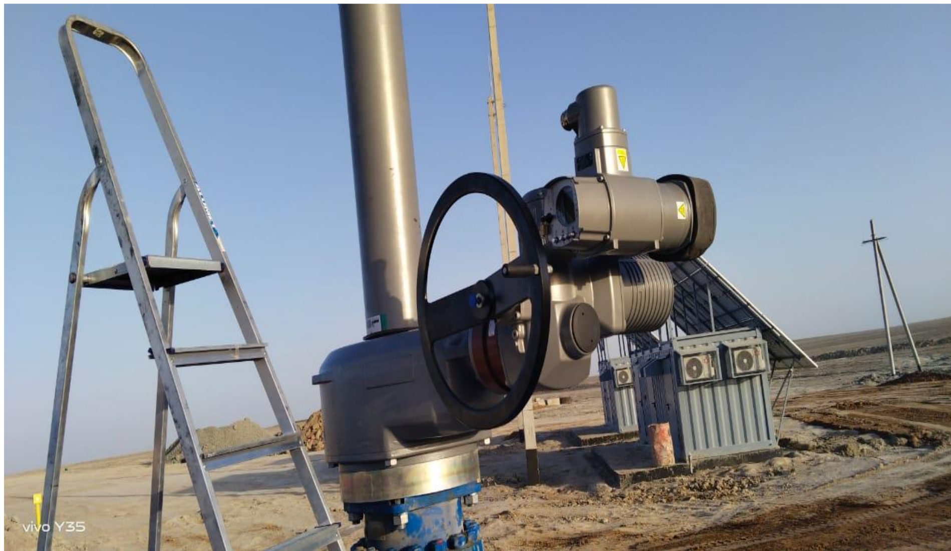
Установка привода и корпуса для задвижки Ду1200 компании ЛКУ на 184 км комплекса 3
