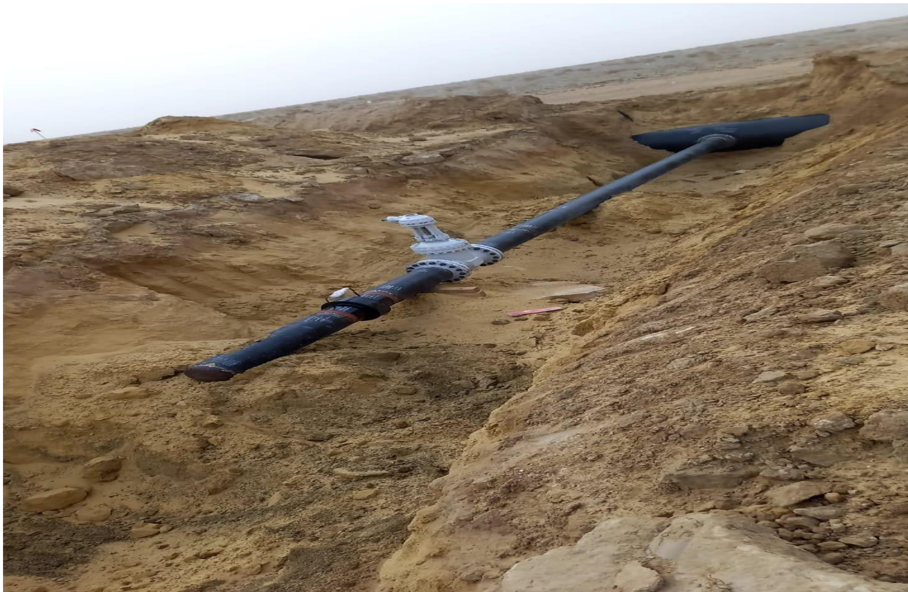
Сварка труб водозабора в ПК110 Комплекс 4 Бейнеу
